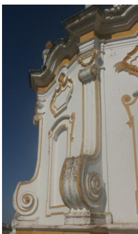
Figura 11: Santuário de Nossa Senhora de Aires, «volutas-contrafortes do zimbório, iniciado em 1745
